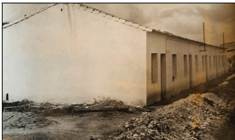
Viviendas construidas en la calle La Paz (septiembre 1963)
