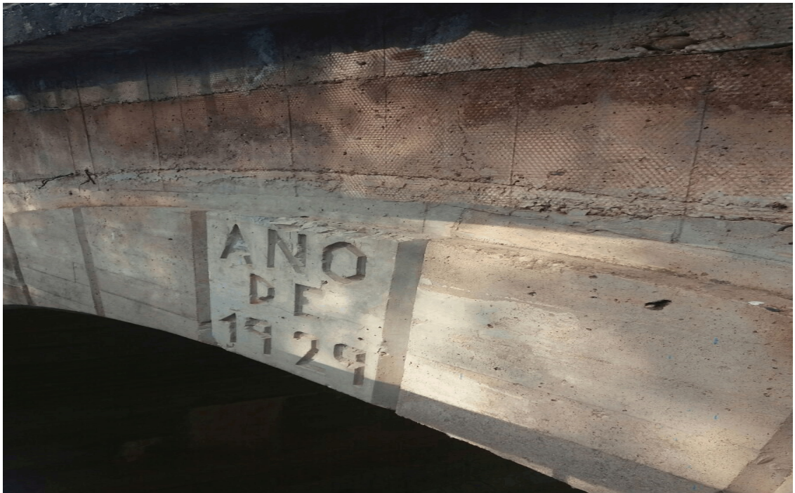
6. Puente sobre el Guadalimar (detalle de la fecha)
