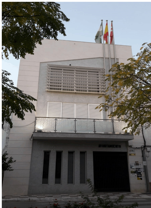
26. Ayuntamiento (edificio actual)
