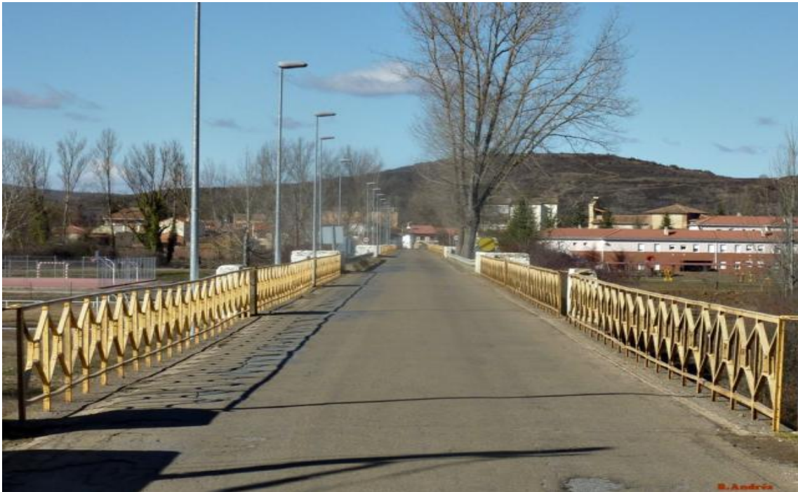
GRAÑES. Entrada por el puente sobre el río Esla
